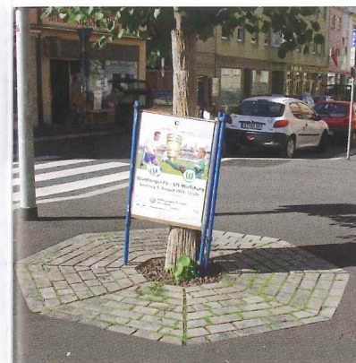
Eine zu kleine Baumscheibe in total versiegelter Umgebung
